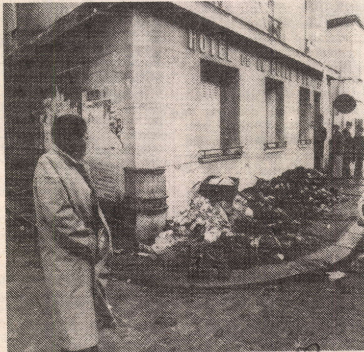
Le foyer-hôtel rue de Chalon après l'incendie.
