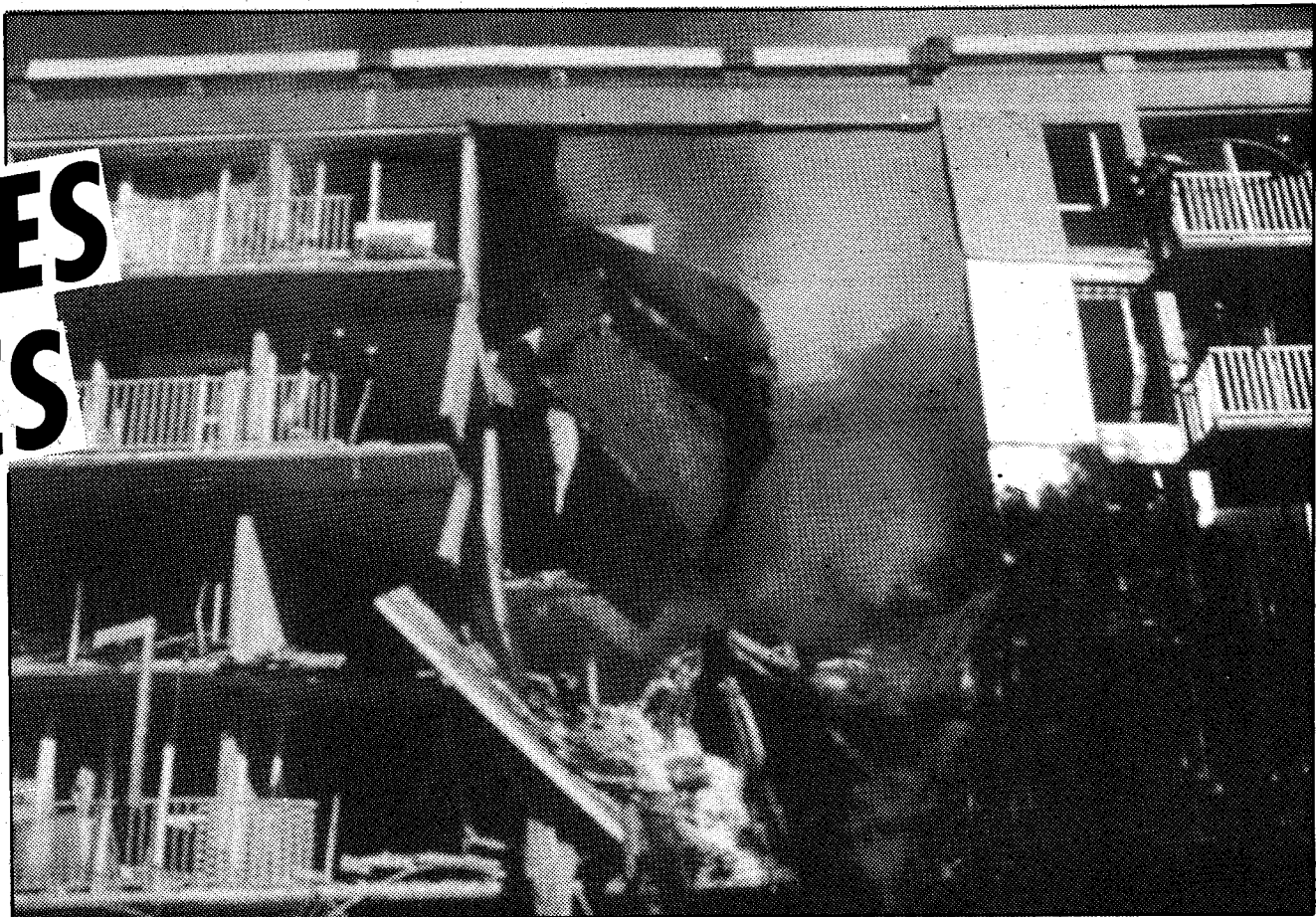
Une explosion due au gaz, et tous les planchers de l'immeuble se sont décrochés des parois.
