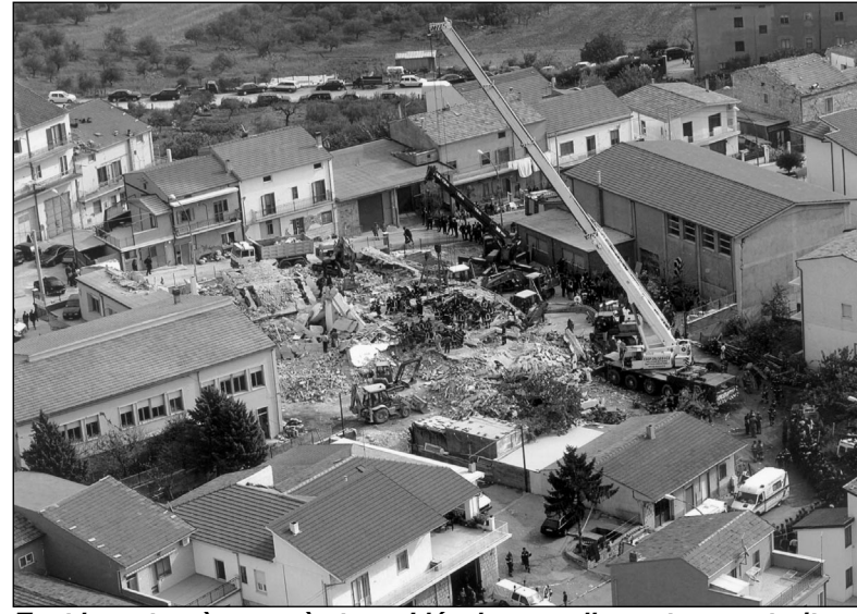
Tout le reste a à peu près tenu. L'école nouvellement reconstruite s'est effondrée.
