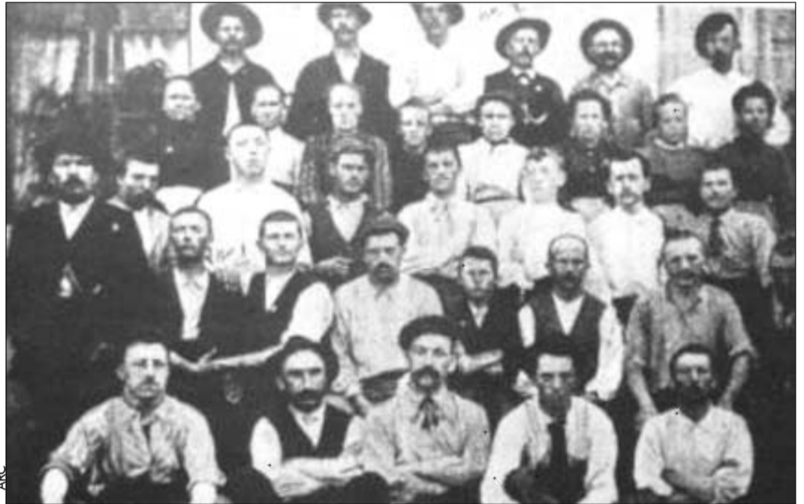
Les ouvriers de l'usine Crettiez en grève.
