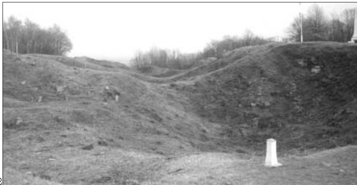
86 ans après, la butte de Vauquois, en Argonne, est toujours éventrée par les cratères dus à la guerre des mines (des charges souterraines ont fait disparaître le sommet de la colline). Des milliers de soldats ont péri sur ces quelques hectares.
