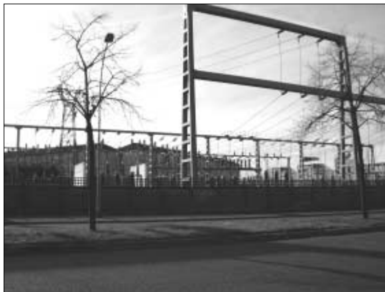
Un transformateur EDF en région parisienne. Protégé par un mur surmonté par un quadrillage de béton, il est assez facile à franchir. De l'autre côté du poste EDF, on voit des bâtiments.
