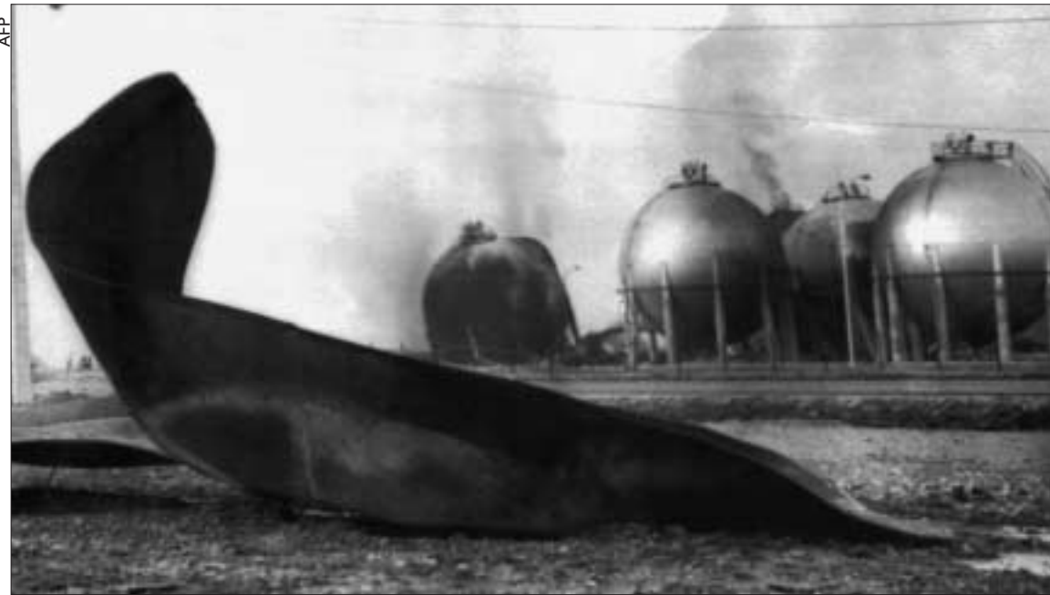
Une pièce métallique, projetée par l'explosion d'une des cuves en feu.
