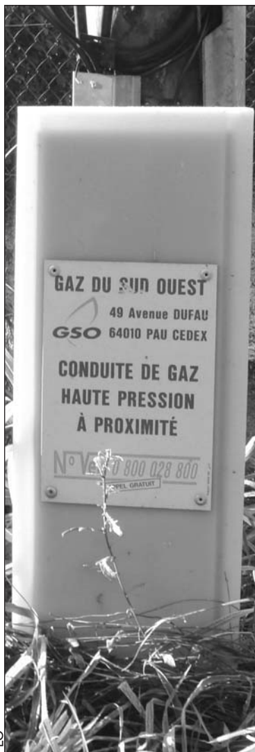
Dans le Sud-Ouest le gaz de Lacq est aussi dur à la détente.
