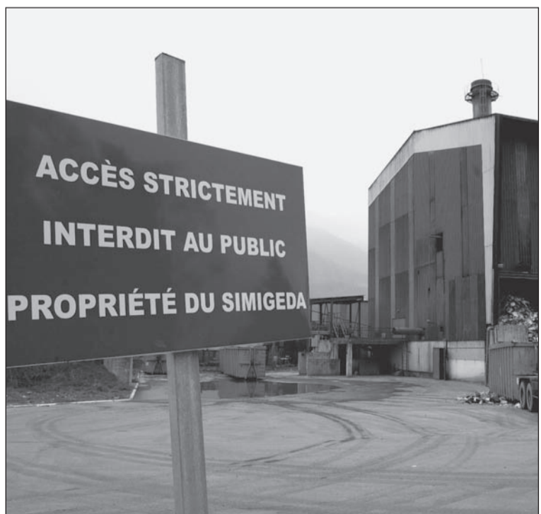
Usine d'incinération d'ordures ménagères à Gilly-sur-Isère en 2005.
