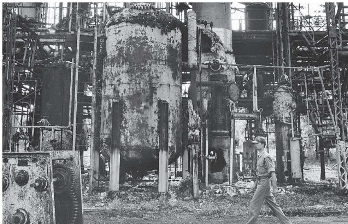
Les ruines de l'usine de Bhopal.
