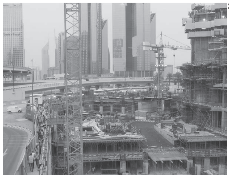
Un chantier à Dubaï.
