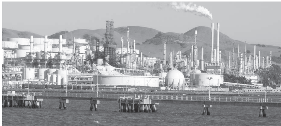
Raffinerie de pétrole dans la baie de San Francisco
