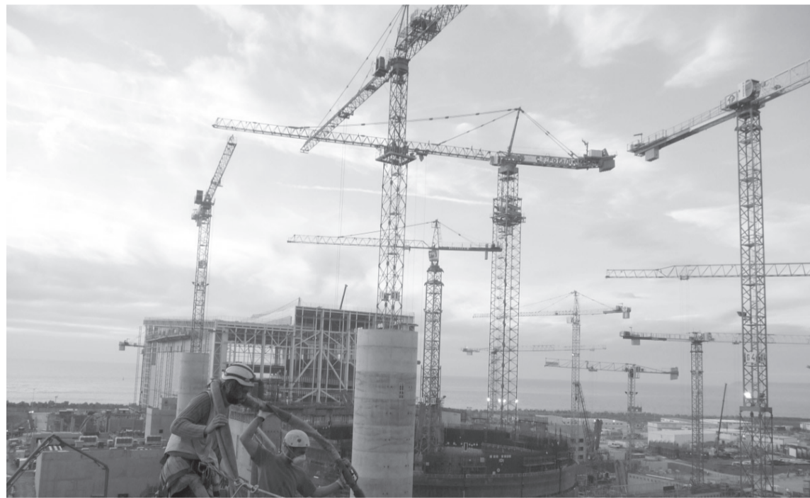
Le chantier de l'EPR de Flamanville.
