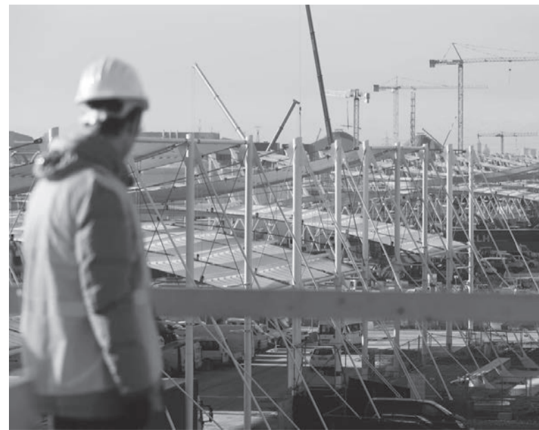
Sur le chantier d'Expo Milan
